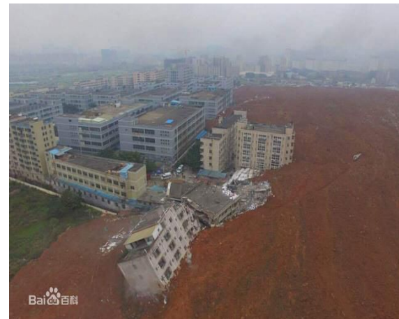
2015.12.20 深圳 山体滑坡 73人死亡、4人失踪，经济损失 8.8亿余元
